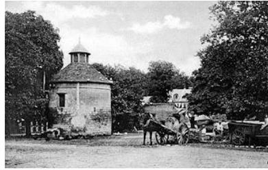
Elle possède un pigeonnier cylindrique muni d'une toiture à lanternon. Au XIX<sup>e</sup> siècle, cette fuye devint un réservoir d'eau pour alimenter l'habitation grâce à un bélier hydraulique.
